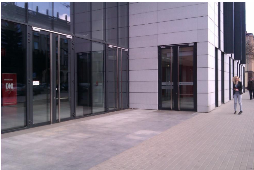
Główne wejście do budynku na jednym poziomie z chodnikiem. Obszar wejścia odróżnia się kolorystycznie od fasady
